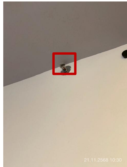
ภาพที่ 4 แสดงหัวกระจายน้ำดับเพลิงอัตโนมัติภายใน ห้องพักแขก
