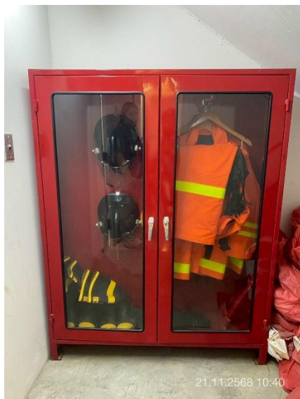
ภาพที่ 11 แสดงตู้เก็บชุดและอุปกรณ์ดับเพลิง
