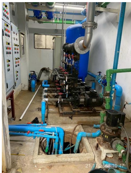
ภาพที่ 23 แสดงห้องปั้มน้ำและถังเก็บน้ำใต้ดิน
