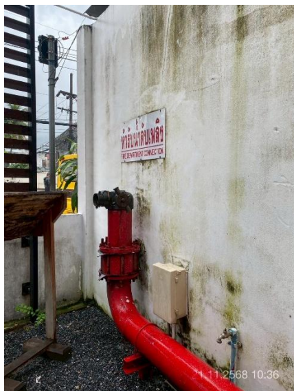
ภาพที่ 19 แสดงหัวรับน้ำดับเพลิงจากภายนอก
